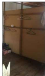
Elemento añadido Pared de playwood
