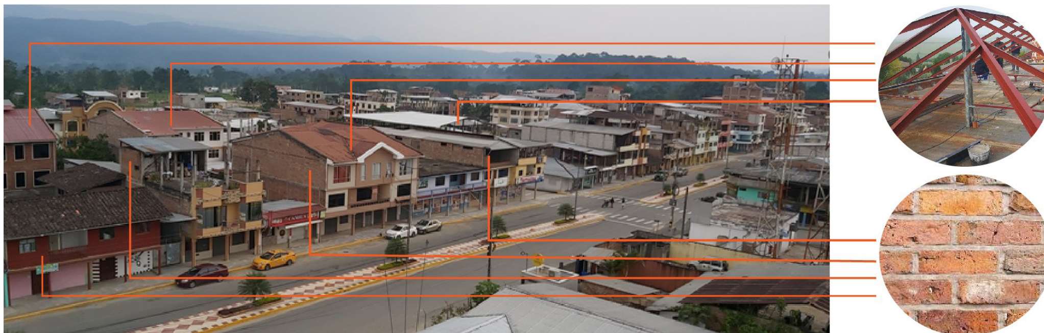
Figura 28. Sistema constructivo predominante
