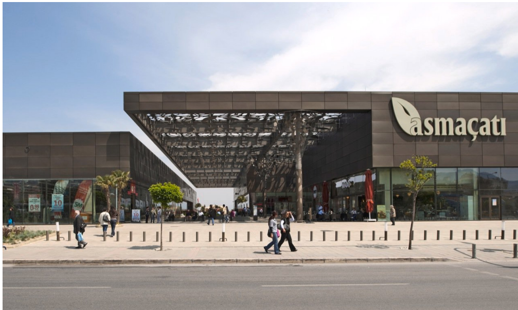
Figura 37. Centro Comercial “ASMAÇATI”
