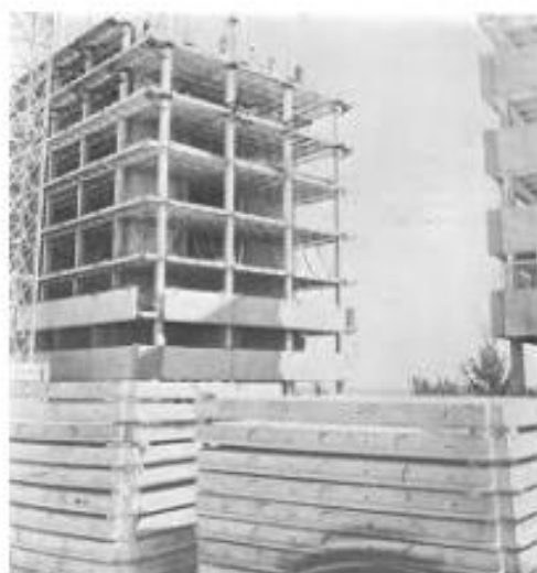
Figura 32. Sistema Estructural Mixto
