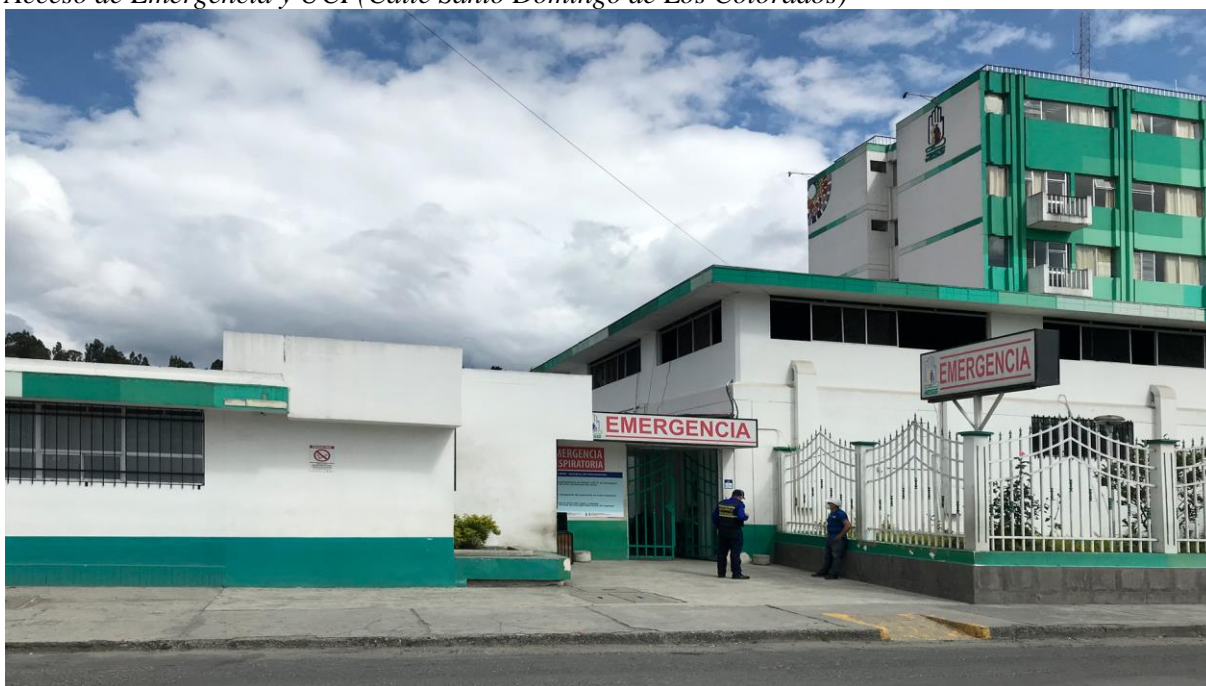
Figura 44. Acceso de Emergencia y UCI (Calle Santo Domingo de Los Colorados)
