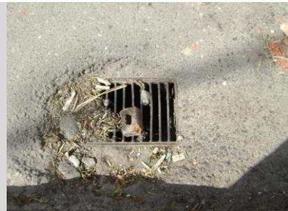
Alcantarilla deteriorada y tapada por asfalto y
