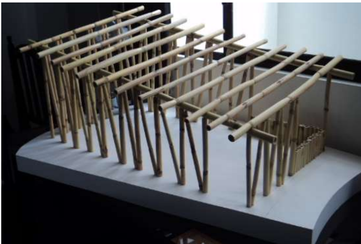
FotografíaN°31: Estructura de Guadua tipo Cercha antes de Colocar la Cubierta de Calcreto Tomada por los autores
