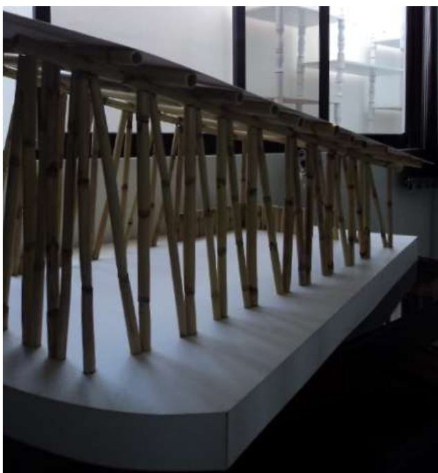
FotografíaN°32: Estructura de Guadua con la Cubierta de Calcreto Tomada por los autores
