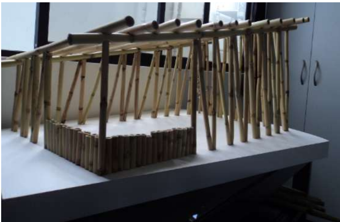
FotografíaN°30: Antepecho de Guadua para colocar Ventanas en un Modulo del Proyecto Tomada por los autores
