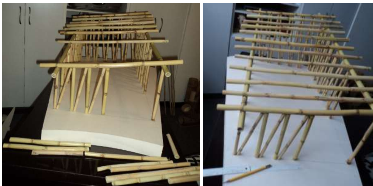
FotografíaN°26: Colocación del carrizo en las paredes en forma de cercha cada 1 metro Tomada por los autores
