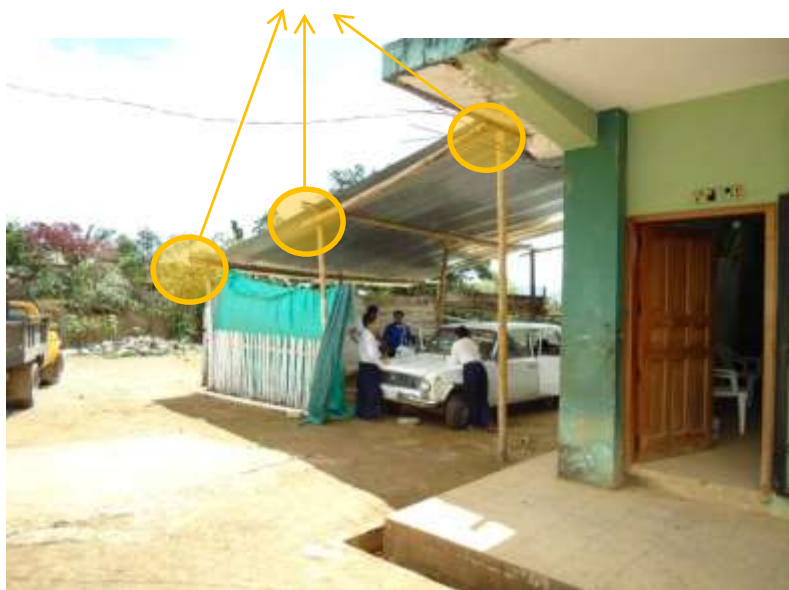
Fotografía N°1: Estructuras realizadas de manera empírica con Guadua, (escuela, Parroquia Ciano del Catón Puyango. Tomada por los autores.
