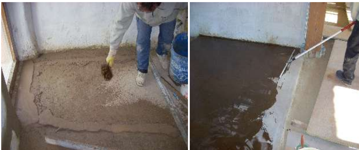
Figura N°45: Procedimiento de colocación de piso
