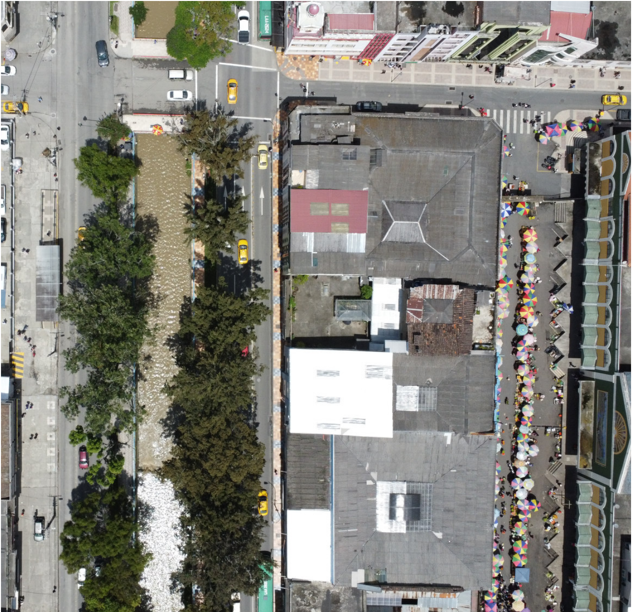
Figura 54. Imagen aérea, Intersección calle 10 de Agosto
