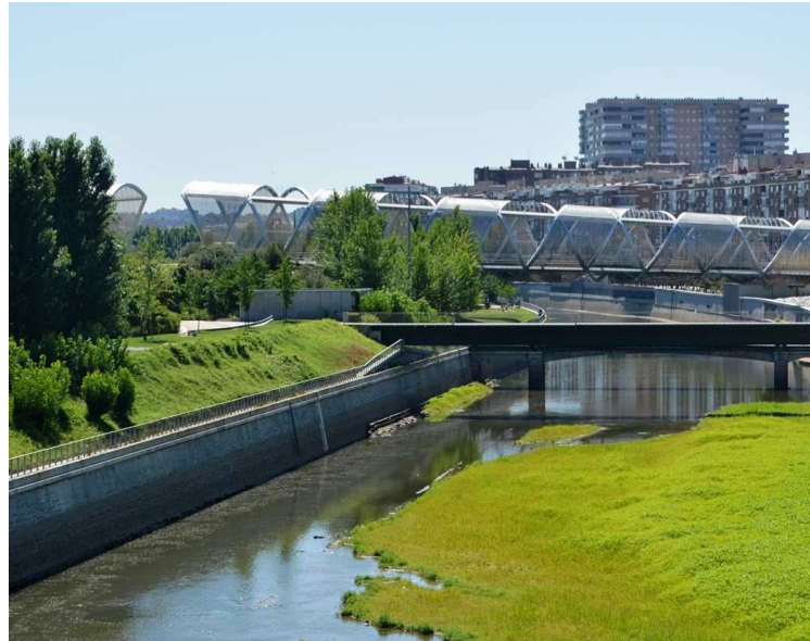
Figura 13. Puente espiral, "Madrid Río"
