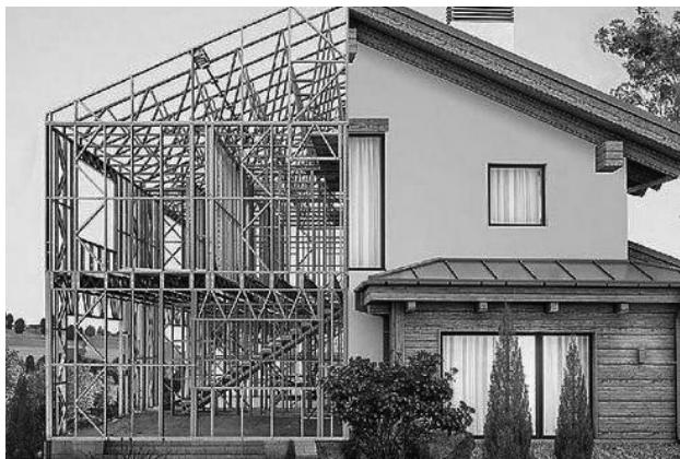
Nota: La figura presenta una vivienda construido con el sistema Steel Framing, tomado de, Freitas y Morales, (2007).
