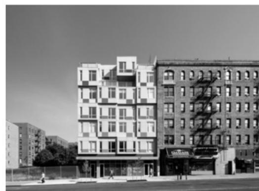
Nota: La figura presenta un colash de viviendas construido con el sistema Steel Framing, elaborado por el autor, (2022).
