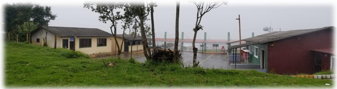
Figura 11 Imagen de la infraestructura de la escuela.
