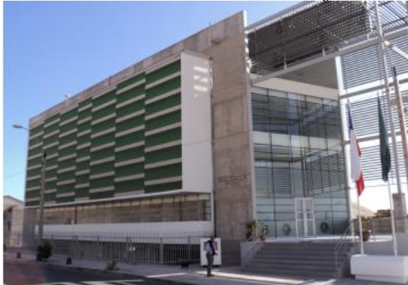
Figura 25 Protecciones solares sobre muros de hormigón armado
