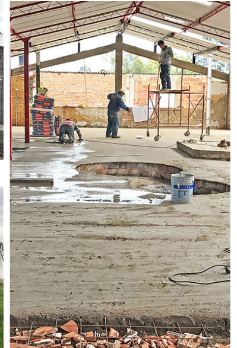
Figura 23: Proceso de Construcción 3 Talentino
