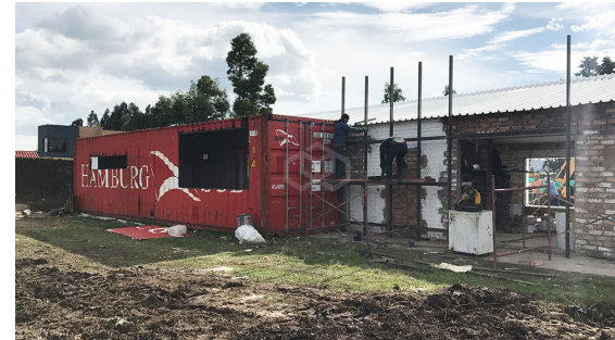
Figura 21: Proceso de Construcción 1 Talentino
