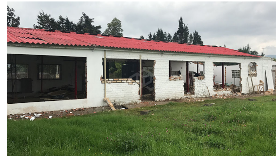
Figura 22: Proceso de Construcción 2 Talentino
