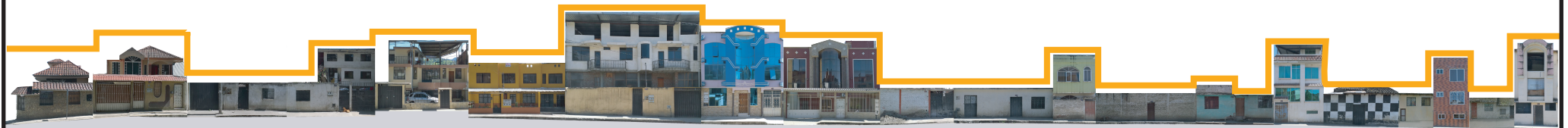
3 Tramo de la Calle El Espectador desde la calle El Comercio hasta la Av. Pablo Palacio
