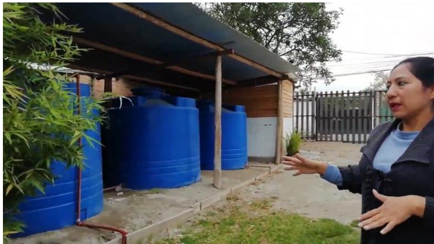
Tanques de almacenamiento de agua para enfriamiento de alambiques.
