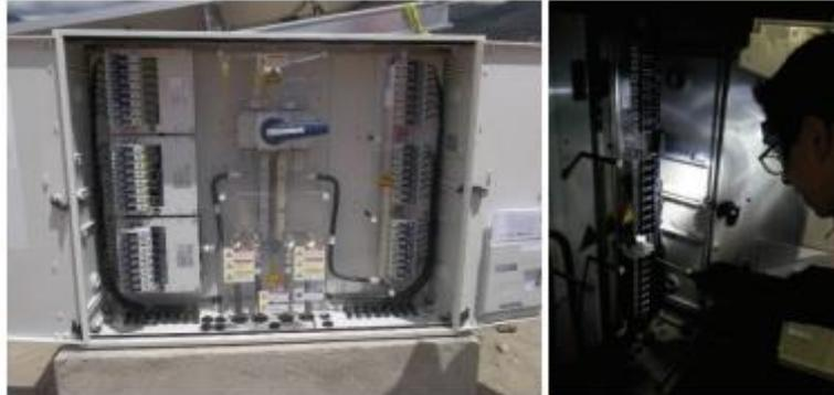
**Figura 21. Cajas de conexión de strings**
