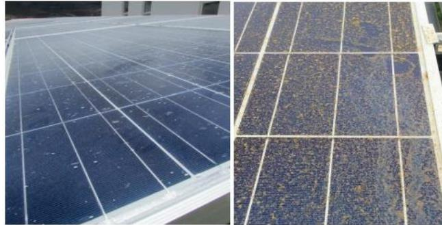
**Figura 20. Suciedad sobre los paneles**
