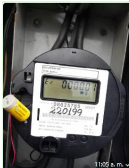
**Figura 30 Cambio de batería de litio error 000001**
