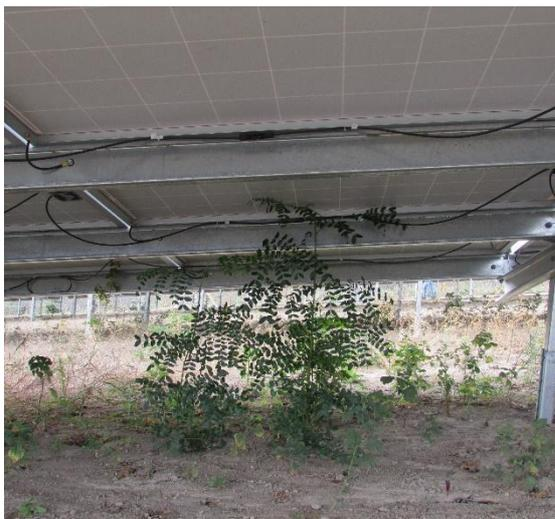
**Figura 22 Maleza en la parte inferior de los módulos**
