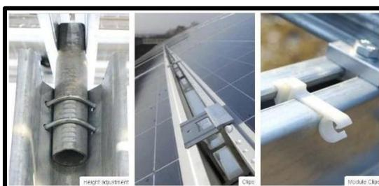
**Figura 13 Esquema de fijación de los paneles en estructura**
