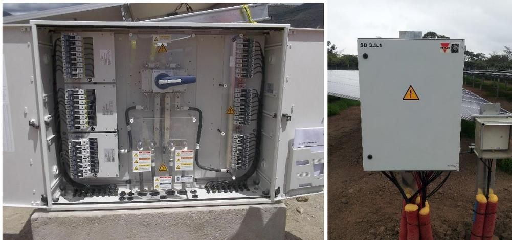
**Figura 28 Cajas de conexión de strings**
