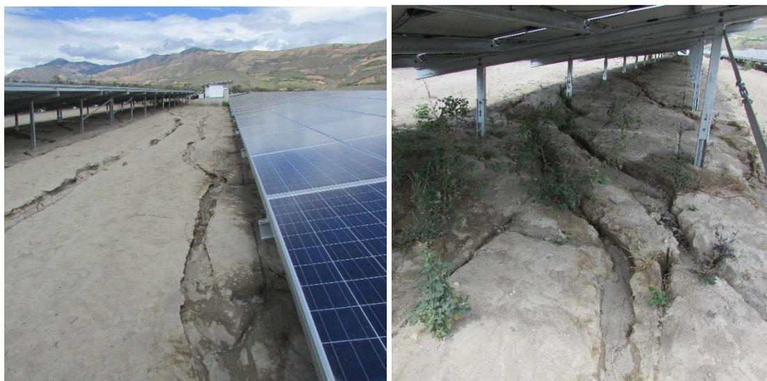
**Figura 23 Grietas en el terreno de un parque fotovoltaico**
