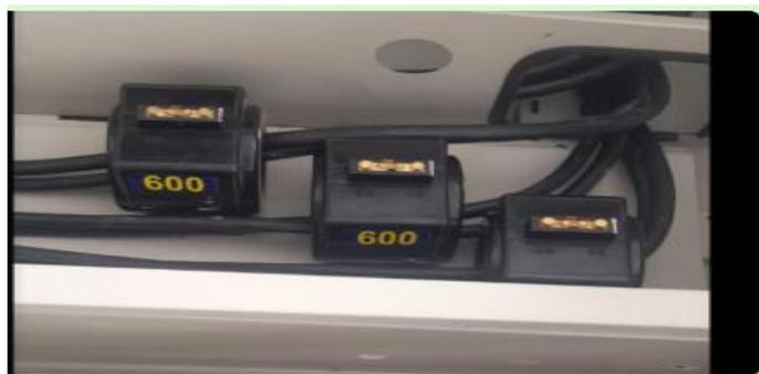
**Figura 31 Transformadores de corriente tipo ventana 600/5**
