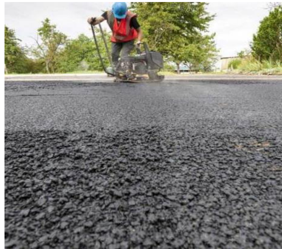
Figura 5.55. Restos de asfalto (Paviconj, 2016)
