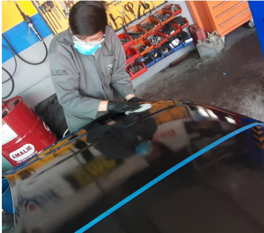
Figura 4.37. Limpieza exceso de producto (Autores 2022)
