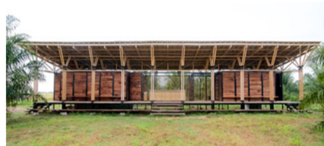
Figura 44. Proyecto en madera de bambú
