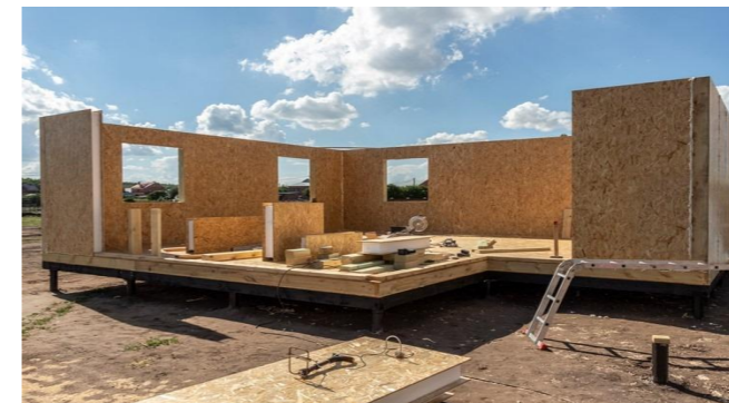
Figura 45. Trabajo de construcción in situ.
