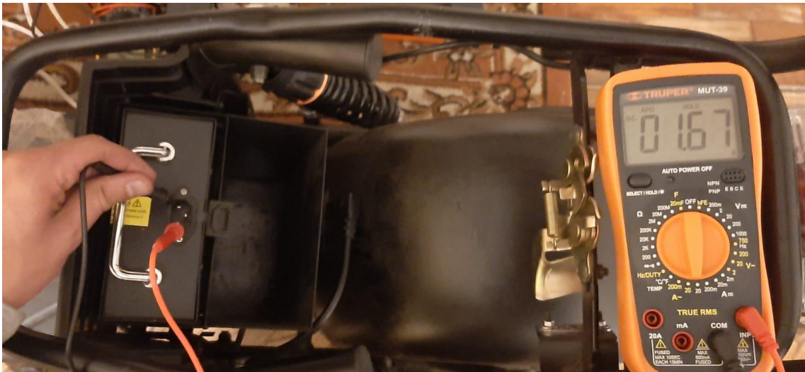
Fig. 5.12. Amperaje posterior a prueba Ruta La Carolina (2 ocupantes). Fuente: Autores.
