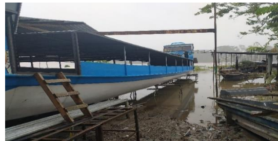
Figura 1: Embarcación en construcción Fuente: (Autores)
