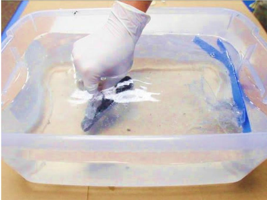
Al sumergir la pieza se debe hacerlo con calma y lentamente. Se observará como la película comienza a envolver y adherirse sobre la superficie de nuestro objeto. Después de haberlo sumergido en su totalidad, se levanta la pieza y se permite escurrir el exceso de líquido. Si la impresión fue exitosa se verá el diseño plasmado de forma uniforme.
