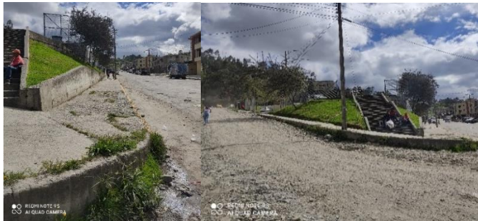
Figura 51. Aceras y calzadas
