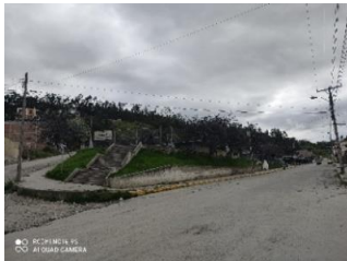
Figura 33. Vista del ingreso principal
