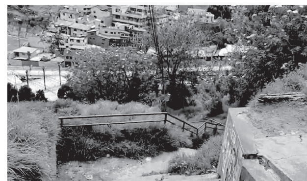
Condiciones Físicas del acceso
