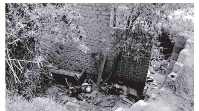
Condiciones Físicas del acceso
