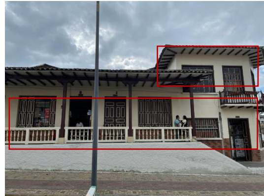
Figura 79 Fachada Este Mercado San Sebastián
