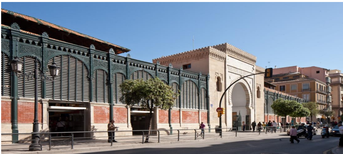
Figura 67 Fachada frontal Mercado municipal de Atarazanas
