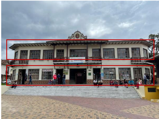
Figura 78 Fachada Norte Mercado San Sebastián
