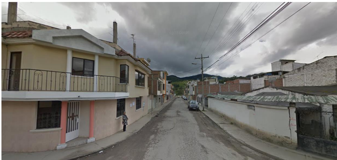
Figura 68. Estado actual de la calle Pedro Pablo Rubens
