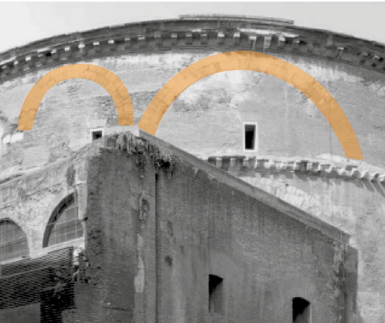
El muro perimetral del Panteón está compuesto por ocho grandes nichos, alternados por otros ocho grandes machones. El muro es de 6m de espesor el cual soporta aproximadamente 10.000 toneladas del peso de la cúpula; sin embargo, el arquitecto romano no
