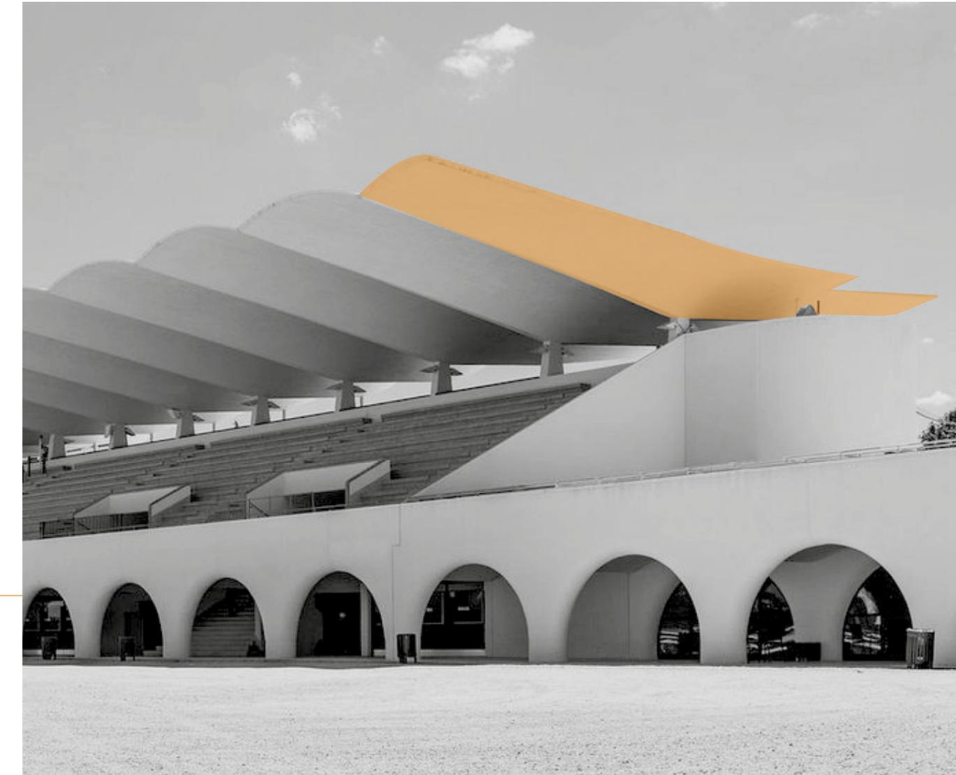
hubiese utilizado la geometría de semicilindros para la conformación de su cubierta no hubiese sido posible esa forma, esa esbeltez ni tampoco esa resistencia, seguramente hubiese necesitado de más apoyos y la idea de ligereza transformaría totalmente el proyecto; la geometría que Torroja usó fue la mitad de un hiperboloide, que nuevamente gracias a la doble curvatura de esta geometría es posible que la cubierta sea tan fina y resistente.
