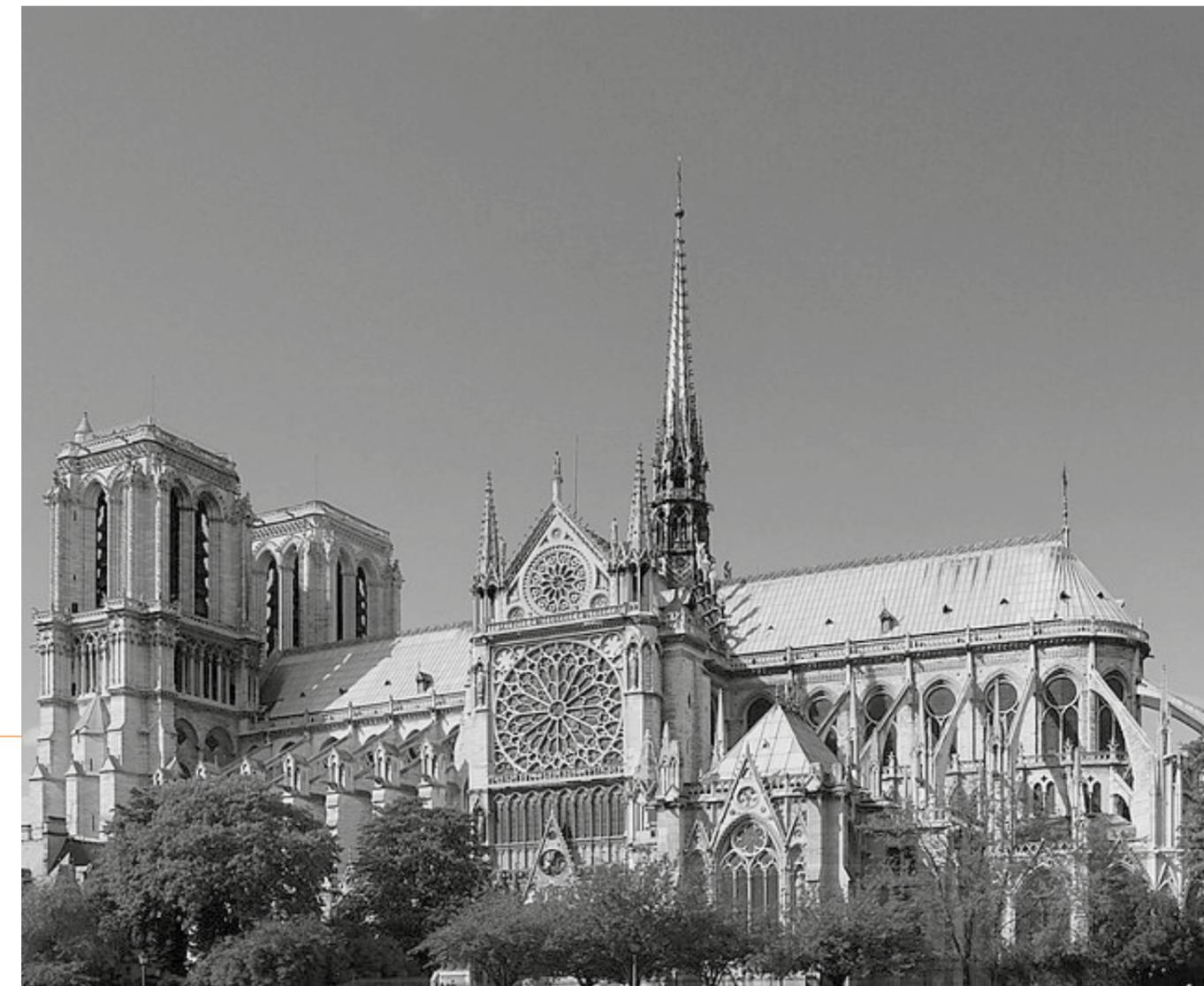
reforzada por el hecho de que, desde el interior nada puede ver de la razón técnica por la cual se mantiene en pie una construcción tan vertical; que es la razón de ser del soporte estructural gótico “gracias a cuatro ingenios: la bóveda de arista, el arbotante, el contrafuerte y el pináculo” (Addis, 2007).
