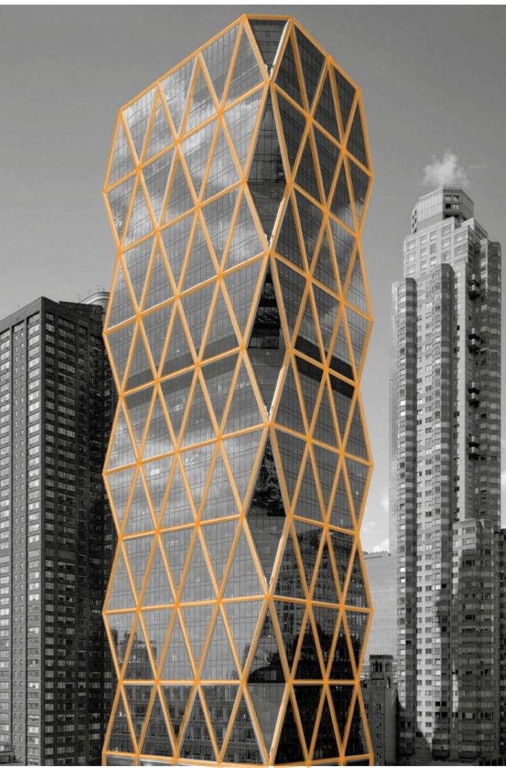
York, para la envolvente del edificio se utilizó pilares separados por una distancia entre 1,2 y 4,6 m entre ejes, y vigas entre 61 y 122 cm de canto.
