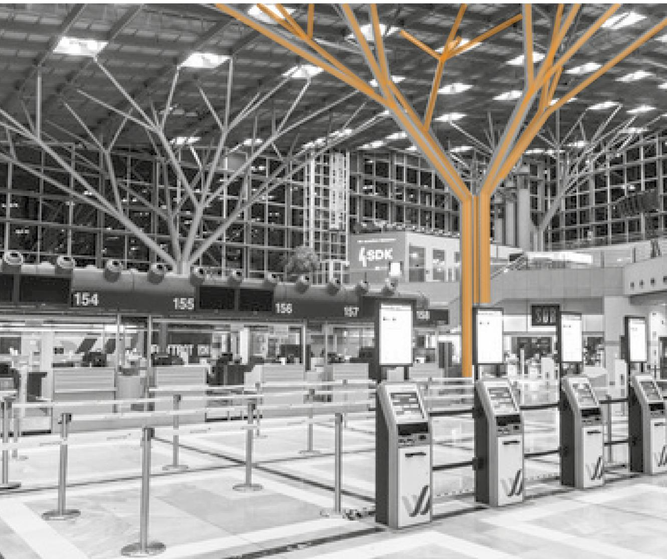
bandas de los lucernarios subdividen en doce módulos el plano de la cubierta inclinada, los cuales se apoya en una estructura con forma de árbol.
