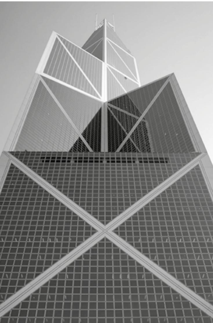
terminan en la planta 90, dos en la planta 66 y otros dos en la 55. La disminución de la altura de los módulos reduce el balanceo provocado por el viento, ya que rompe el flujo del mismo.
