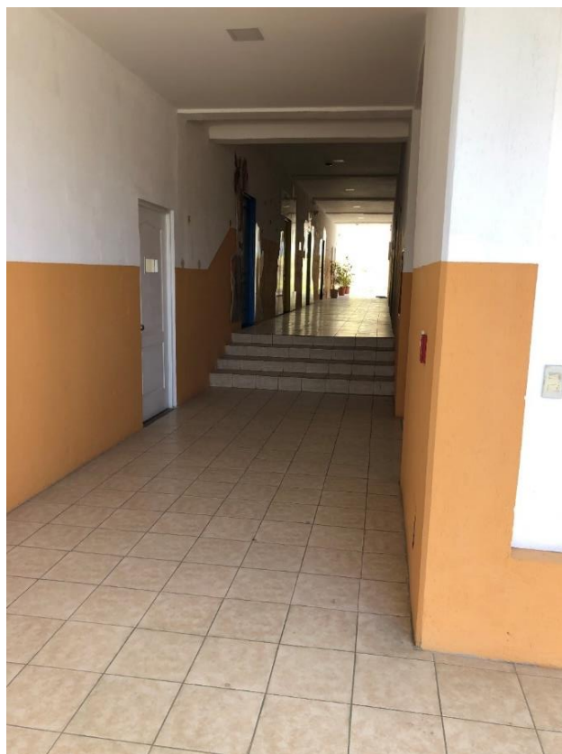
Ilustración 9 Acceso al pasillo de los bloques en el primer piso Fuente: Fotografía tomada por el autor
