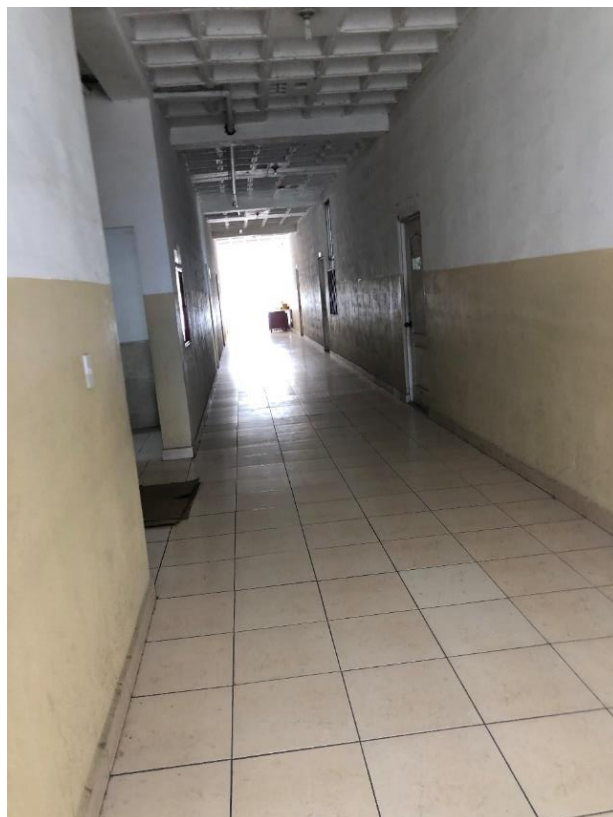
Ilustración 8 Acceso al pasillo de los bloques en el segundo piso Fuente: Fotografía tomada por el autor
