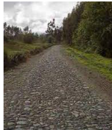
Figura 6. Vía de pruebas empedrada. Fuente: Autores
