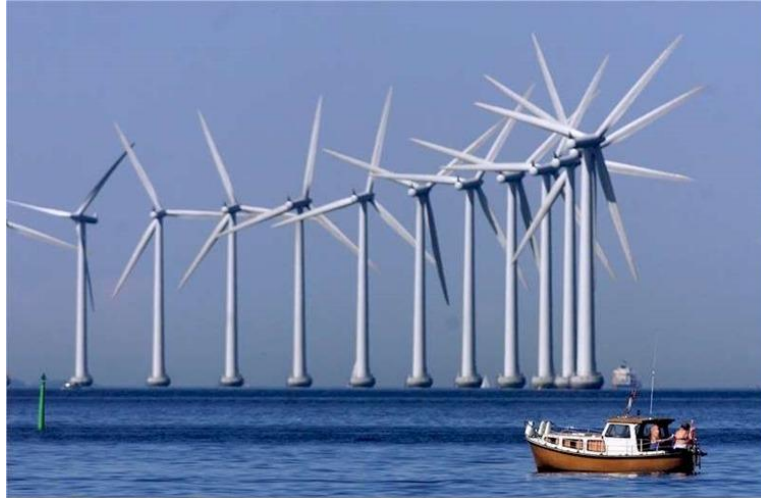
Figura 2.7 Energía eólica en Dinamarca
