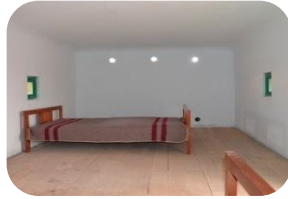
Muro trombe - vista desde el dormitorio
