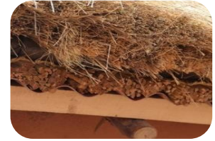
Cubierta con paja como aislante
