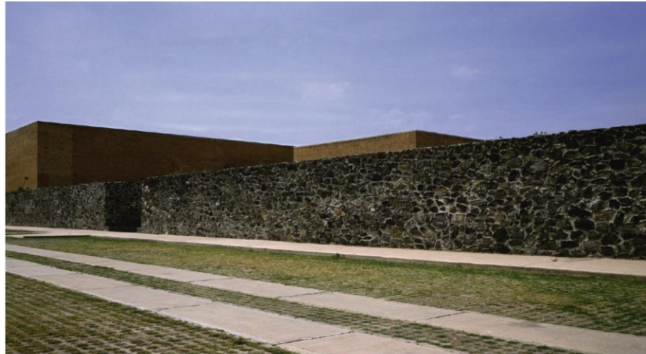
Muro exterior de piedra
