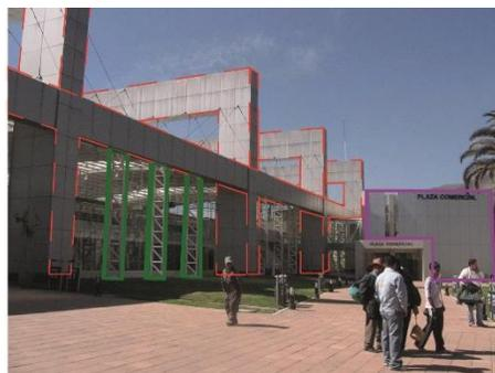
— Columnas de hormigón revestidas con Alucobond
