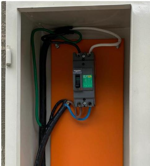
Posteriormente se realizó la ubicación, conexión y fijación del equipo de carga para vehículos eléctricos dentro del gabinete metálico tal como se muestra en la figura 35.
