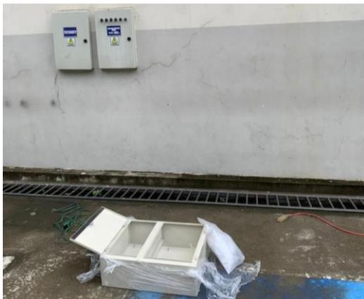
Para el proceso de empotrado de dicho gabinete metálico fue necesario realizar un agujero de medidas exactas para la fijación del mismo, adicional se realizó la implementación
