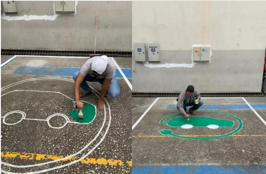
Una vez culminado el proceso de señalización, se procedió a esperar unos minutos para poder retirar la cinta, obteniendo como resultado la señalización del parqueadero designado para la carga de vehículos eléctricos, como se muestra en la figura 43.
