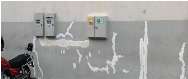
Luego de esperar unas horas para que el empaste seque adecuadamente, se procedió a lijar la zona eliminando las imperfecciones, como se muestra en la figura 45.
