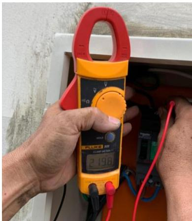
Una vez realizada la implementación del equipo se procedió a encender el mismo verificando que la alimentación del voltaje está funcionando de una manera adecuada, tal como se muestra en la figura 37.
