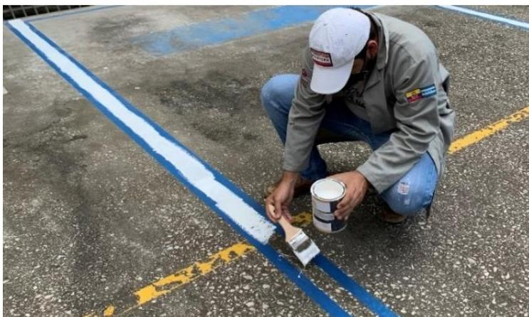
Una vez delimitada la zona, se realizó el diseño de un logo con pintura vial de color verde y detalles en blanco para identificar que este parqueo tiene como preferencia los vehículos eléctricos que harán uso del equipo de carga, como se muestra en la figura 42.
