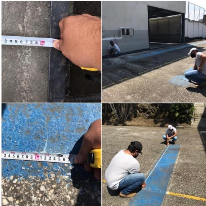
Una vez marcada la zona con la cinta, se procede a pintar usando los materiales y las herramientas adecuadas para este tipo de señalética; es decir, la pintura vial de alto tráfico color blanco para establecer la zona que usara el vehículo eléctrico, como se muestra en la figura 41.
