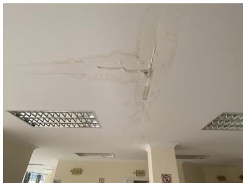
DESCRIPCIÓN: La no impermeabilización en la losa de cubierta genera humedad por filtración atacando de manera directa a este elemento, existen manchas, fisuras y grietas alrededor de toda la edificación.
