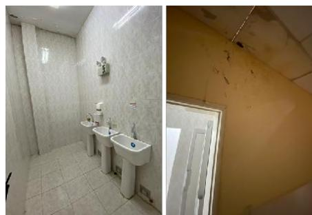
DESCRIPCIÓN: Dentro del área de hospitalización, la humedad por subida capilar en paredes ha causado el desprendimiento del mortero de revestimiento, creando moho en las zonas húmedas, sabiendo que sus esporas pueden producir infecciones respiratorias y alergias.
