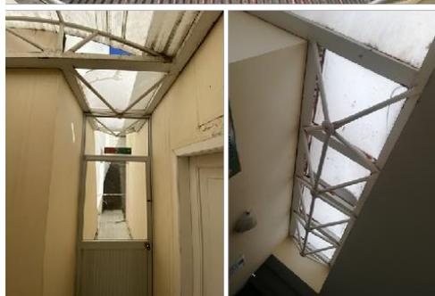
DESCRIPCIÓN: En el elemento cubierta, es notorio (por su diferente coloración) la adición de nuevos elementos, se puede ver que la cubierta ha sufrido varias intervenciones, se observan arreglos a manera de “parches” a lo largo de todo este elemento. Sin embargo, dichos arreglos no han tenido un buen resultado, ya que es evidente como el agua ingresa por la techumbre y destruye el interior de la edificación.
