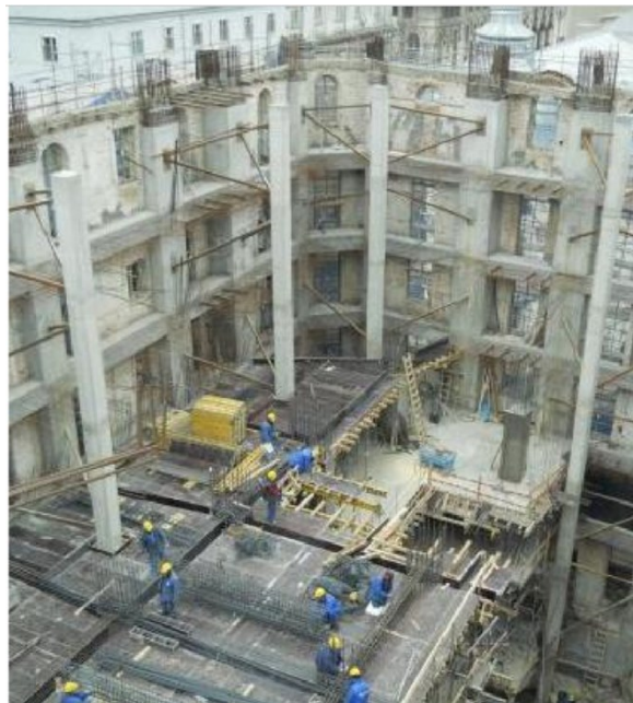
IMAGEN 16: Proyecto rehabilitación integral edificio Cismigiu en Bucarest
