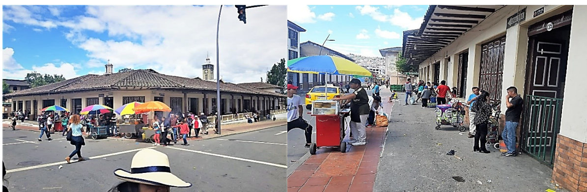
IMAGEN 3: Fachada posterior del mercado San Sebastián
