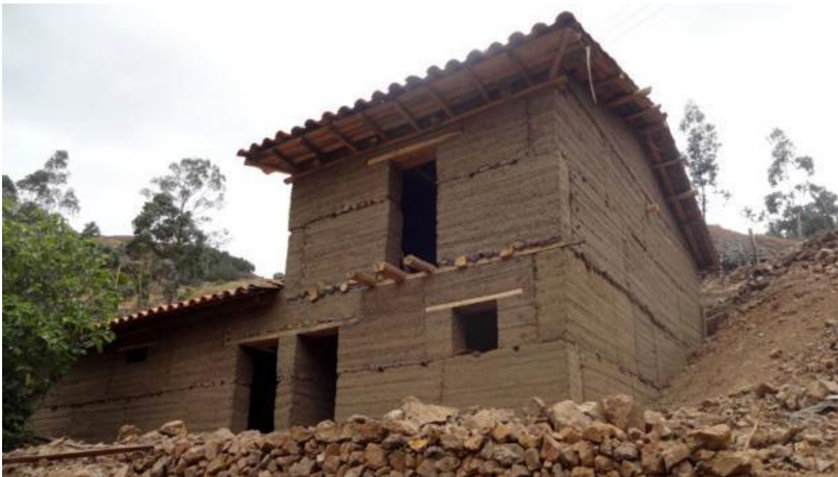
Figura 4. Vivienda de tapial armado
