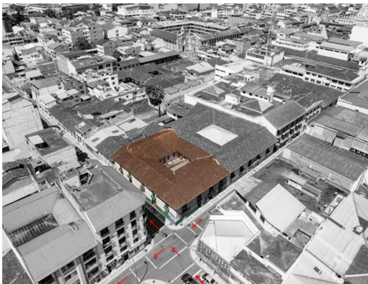
Fotografía 1. Vista en perspectiva del contexto alrededor de la edificación. (2020).
