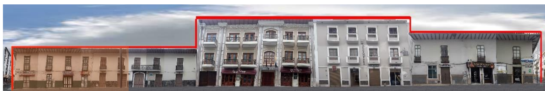
Figura 25. Levantamiento fotográfico calle Bernardo Valdivieso
