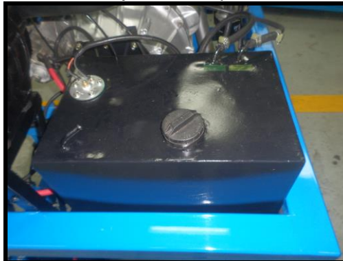
Figura 92: Montaje del tanque de combustible
