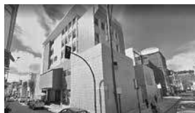
Edificio del Banco Central en Loja.
