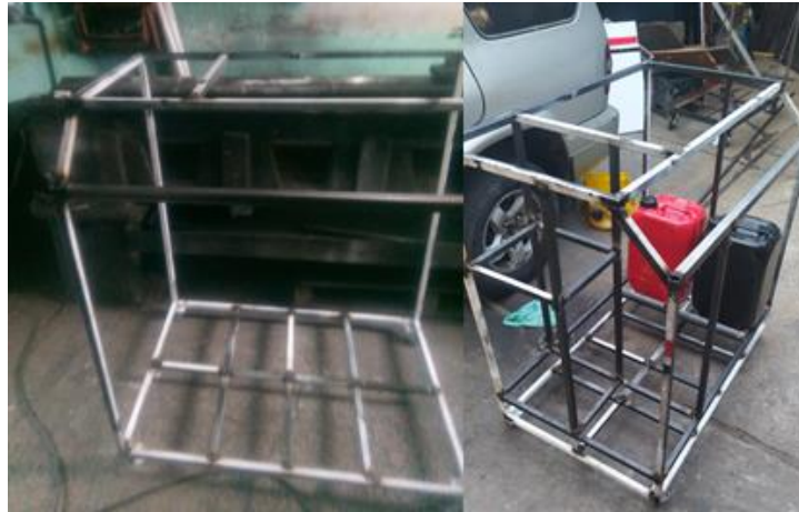
Figura. 4.11. Construcción de estructura del banco de pruebas.
