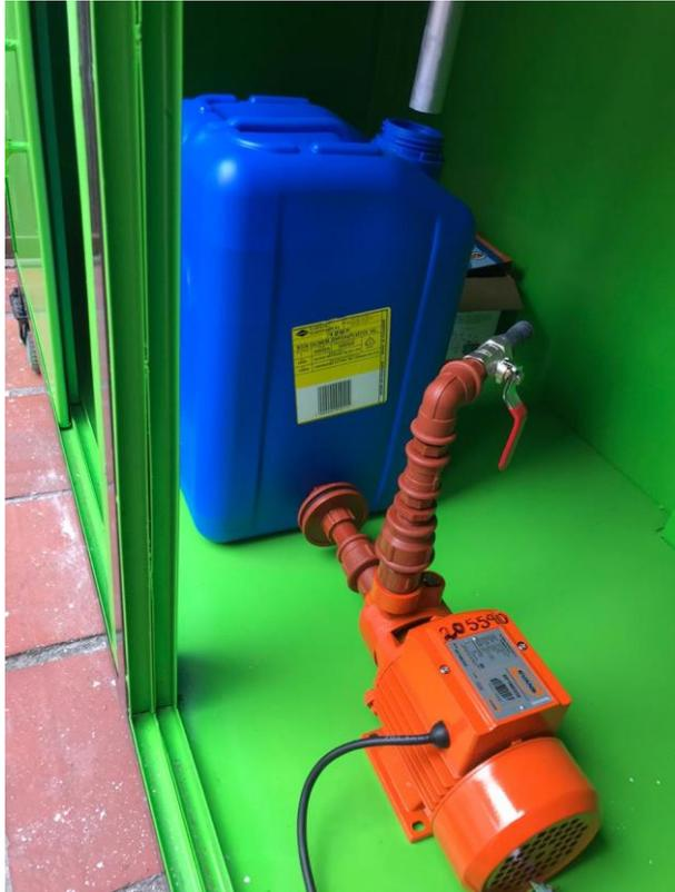
**Ilustración 47.** Apreciación lateral del sistema de limpieza accionado mediante una bomba de agua
