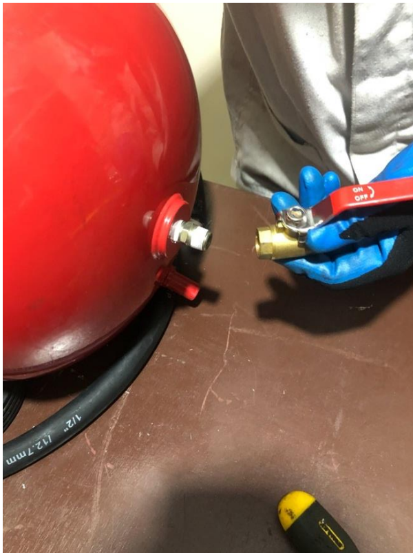
Figura 34 Colocación de llave de paso
