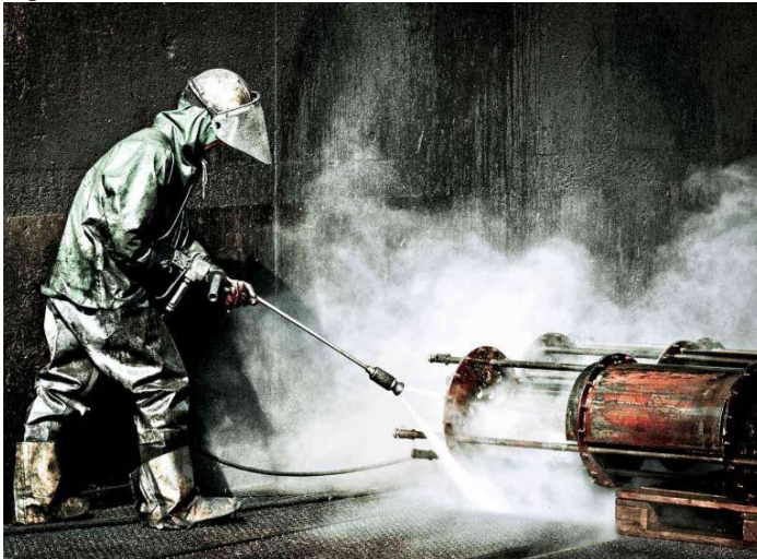
Figura 14 Limpieza por chorro con hielo seco
