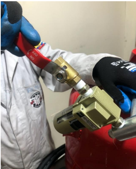
Figura 28 Colocación de llave paso
