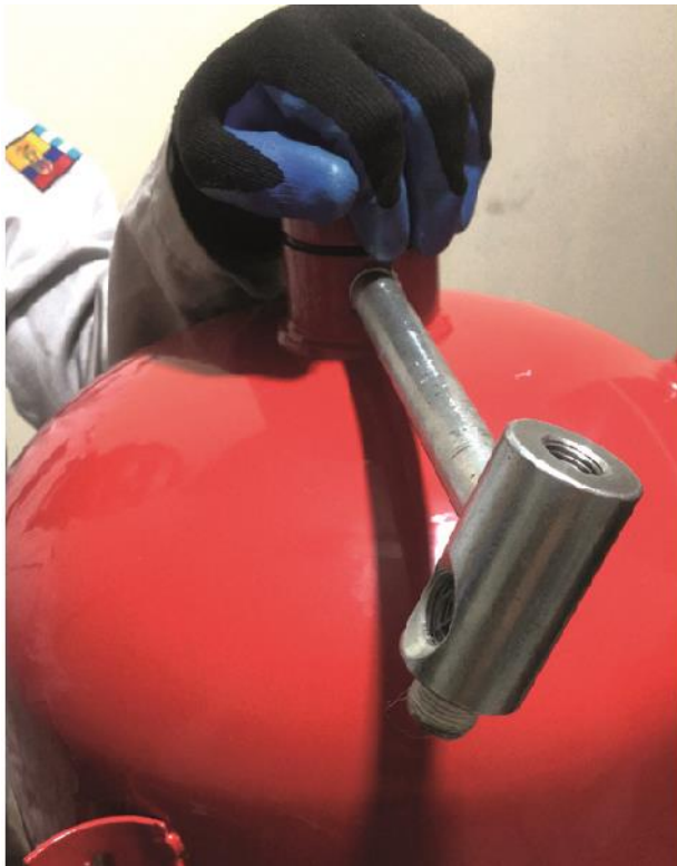
Figura 24 Acople difusor de aire Entrada y salida
