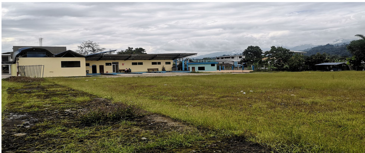
Figura: 76 Fotografía general del Terminal de Paquisha (fuente: Elaboración propia 2020)
