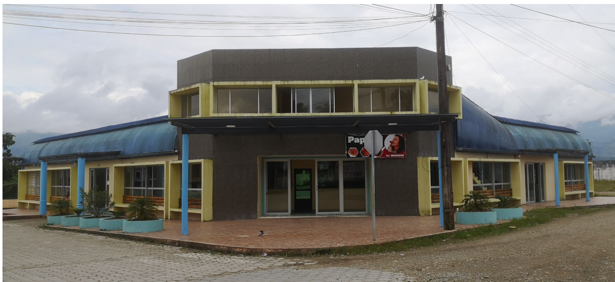
Figura: 75 Fotografía del estado actual del Terminal de Paquisha (fuente: Elaboración propia 2020)
