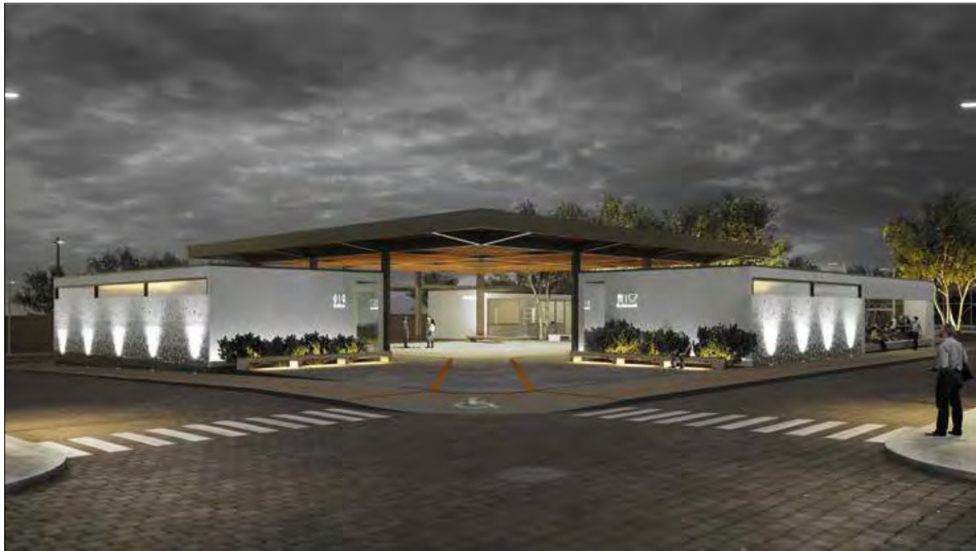
Estación de buses Interprovinciales
