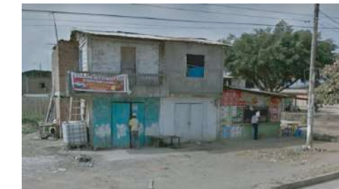
Vivienda collage Hormigón bloque ladrillo mader Techo zinc y teja
