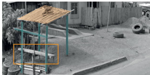
Figura 33. Propuesta Urbana - infraestructura vial (parada de bus)
