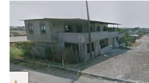
Vivienda en obra gris Hormigón Techo zinc
