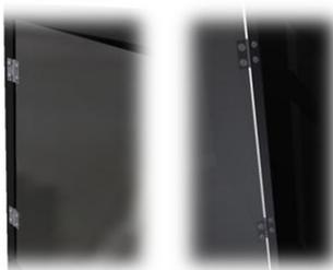
*Figura 3.51 Conexión interna y externa de las bisagras de la compuerta*
