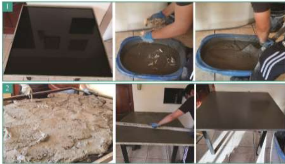
Figura 54. Procedimiento Panel de Micro Hormigón
