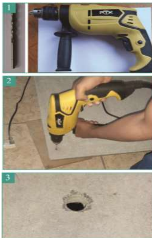
Figura 59. Ensayos de Perforación
