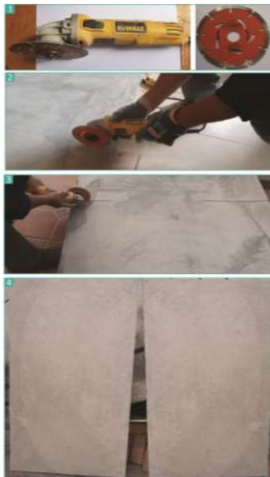
Figura 57. Procedimiento Corte Panel de Micro Hormigón
