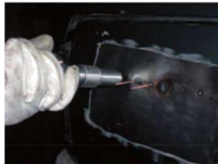
Figura 8.50. Aplicación del martillo de inercia sobre clavos de tracción soldados.
