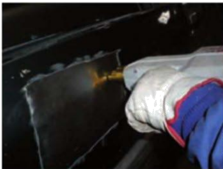
Figura 8.46. Soldadura de una arandela.
