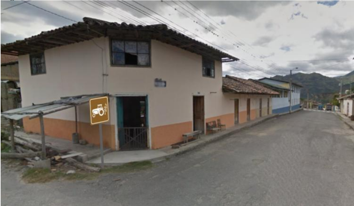
Figura N°38. Ubicación de señal Informativa Chamicos.
