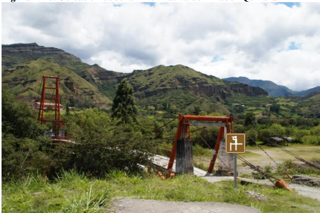
Figura N°26. Ubicación de señal informativa de mirador Quinara
