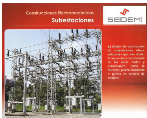
Ilustración 23, SEDEMI Construcciones Electromecánicas
