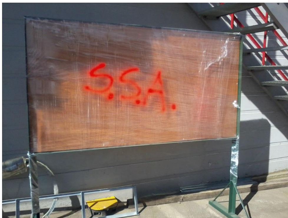
Ilustración 28, SEDEMI Estructura porta cartelera, del autor (Sedemi, Sistema de Gestión, 2013)
