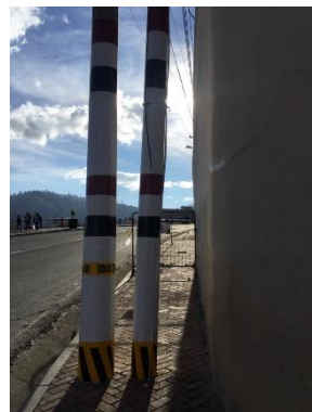
Imagen 29: Circulación peatonal interrumpida
