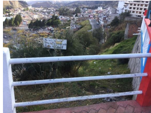
Imagen 28: Afectación a la quebrada
