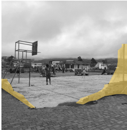
Imagen 3: Afectación a los cerramientos en espacios deportivos Elaborado por: Sebastian Sánchez López, 2018.
