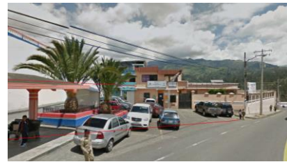
Imagen 18: Fachada Oeste Fuente: Google Earth.
