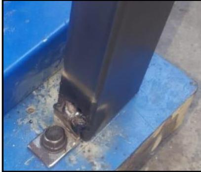
**Figura 44.** Fijación de las bases a la estructura
