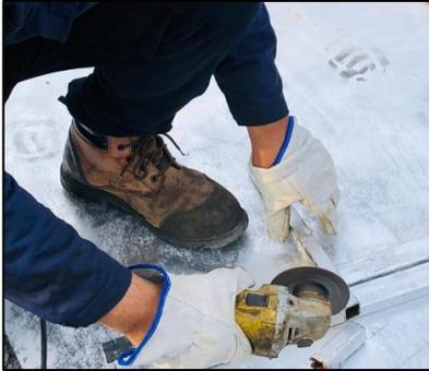
**Figura 42.** Corte de soportes verticales
