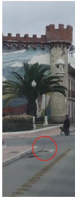
Sumidero de captación de agua
