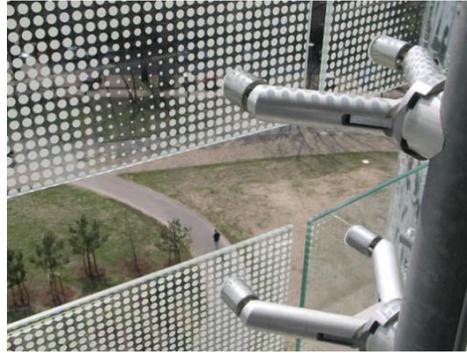
Imagen #15. “Detalle anclaje de vidrio”. Fuente: Herzog y De Meuron.
