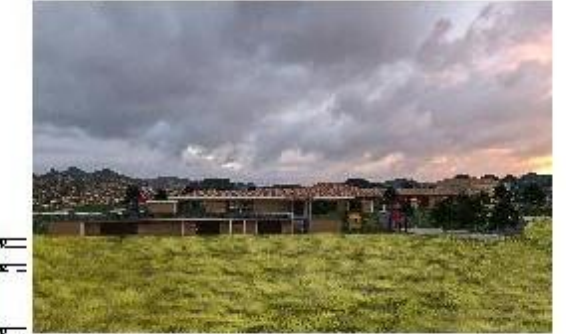
1 FACHADA LADO NORTE
